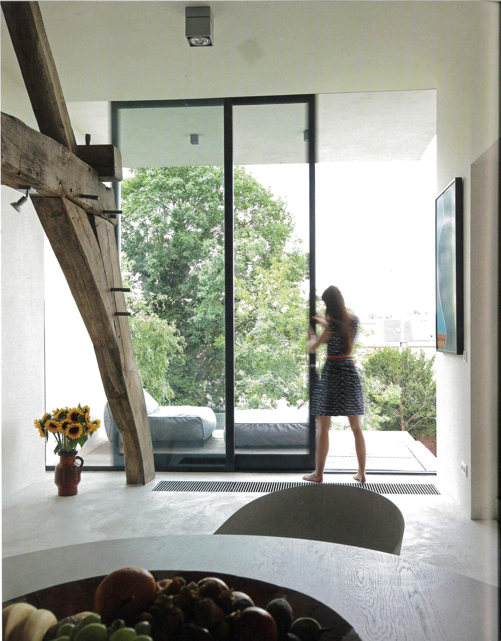
Het zestiende-eeuwse gebinte bleef intact, en werd slechts aan de tuinzijde doorbroken met een witte doos die toegang verschafte tot een terras. Aan de andere zijde werd een rij pannen vervangen door glasplaten die prachtig licht doorlaten. De flat is één open ruimte waarin enkele losse witte wanden staan. De witte vloer zorgt voor extra licht. De slaapruimte zit achter de natte cel, die in een witte doos zit vervat.
